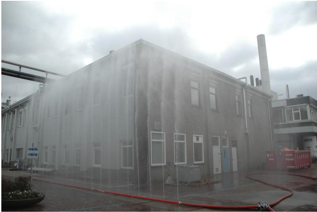
Figuur 6 – Mobiel waterscherm (fire defender) waar diverse brandweerregio's van gebruikmaken.
